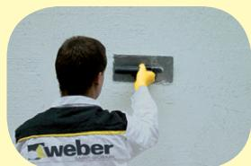
Omítka se nanáší na podklad nerezovým hladítkem na sílu vrstvy danou velikostí zrna. Omítku je třeba napojovat ještě před jejím zavádnutím takzvaně „do živého“. Ucelené plochy provádět bez přerušení.
