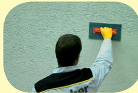
Struktura se vytváří plastovým hladítkem ihned po nanесení. Taž hladítkem musí být stejnoměrně v celé ploše, zvláště v místech koutů, úrovní podlážek lešení apod.
